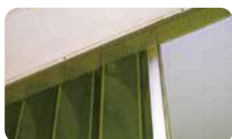
隙間ふさぎシート装着(カーテン外側)
