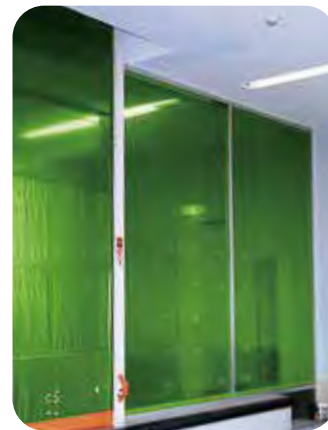
食品工場内の壁
